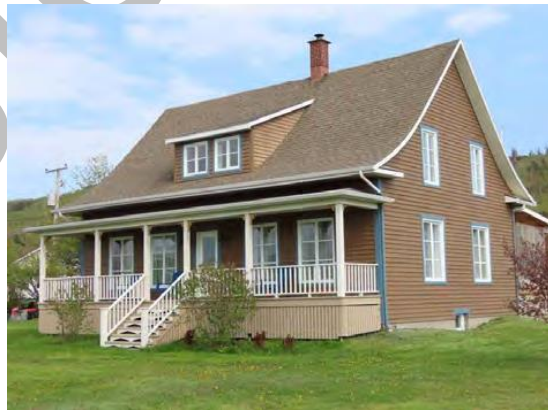
Maison traditionnelle québécoise au toit à deux versants courbés. 282, boulevard Bégin.
