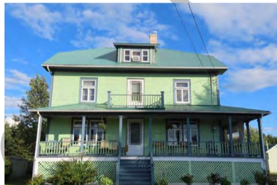
Le 12, rue Grand'Maison, un des édifices dotés d'une valeur d'authenticité excellente.
