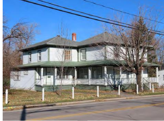
Imposante maison cubique au toit en pavillon, dotée de deux corps de bâtiments. 205, boulevard Bégin.
