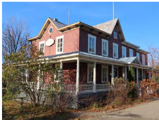
Ancien presbytère de Saint-Pacôme, 224, boulevard Bégin.
