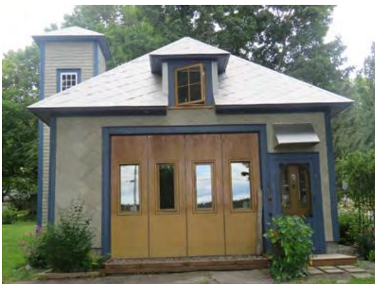
L'ancienne caserne de pompier photographiée en 2020.
