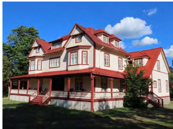
Villa King. 24, rue du Moulin.
